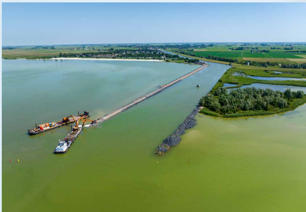
Strekdam in aanbouw
