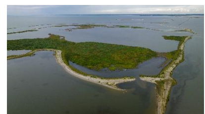
dijkversterking bij de Houtribdijk met behulp van natuur
