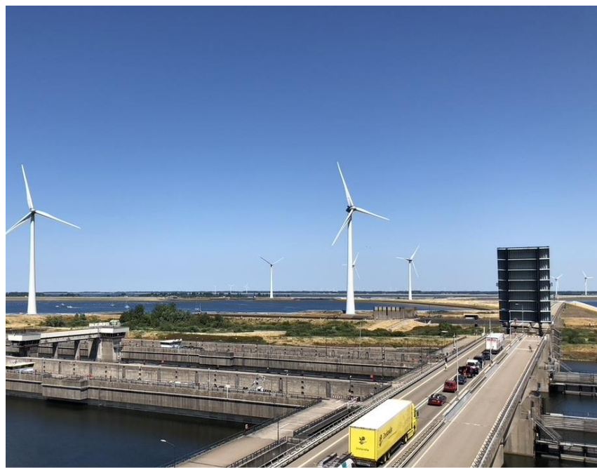
Uitzicht op het Krammersluizencomplex
