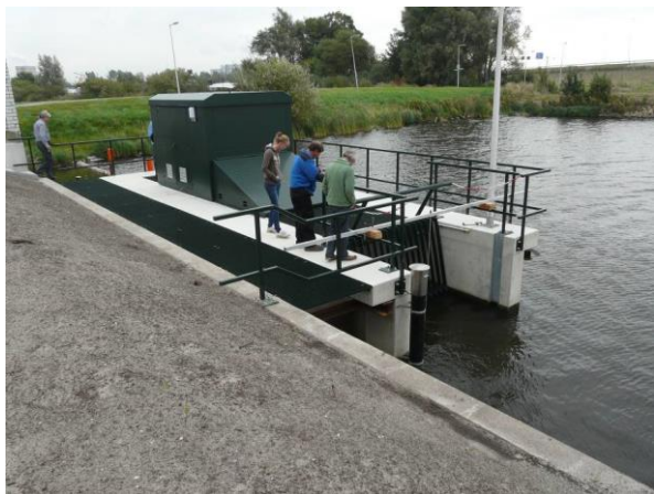
Figuur 3.24 Opvangbak met vijzel en retourstroming zijde Rijnlands boezem, naast gemaal Halfweg (Hoogheemraadschap van Rijnland)
