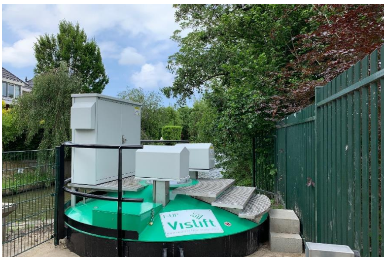
Figuur 3.20 VisliftUp vispassage bij gemaal Voordijkhoornse polder (Hoogheemraadschap van Delfland)
