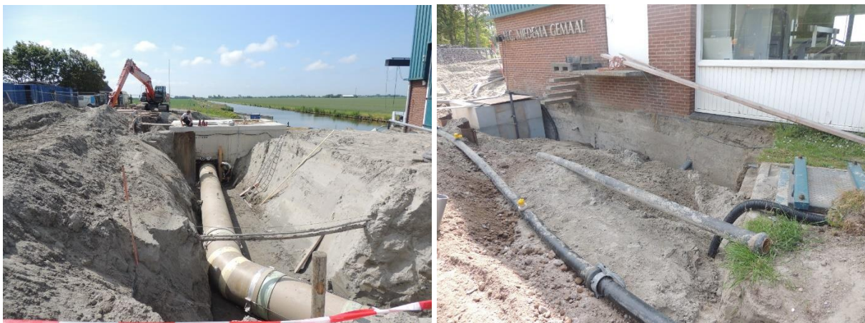
Figuur 3.9 Opvangbak met leiding vispassage gemaal Miedema/Zwarte Haan in aanbouw (Wetterskip Fryslan)
