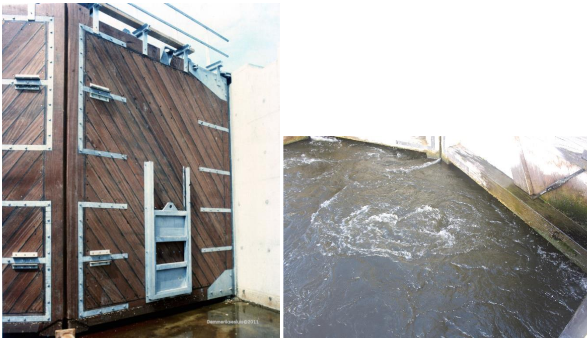
Figuur 3.26 Testen met aangepast schutbeheer schutsluis Demmerik naast gemaal de Ruiter (waterschap Amstel Gooi en Vecht)
