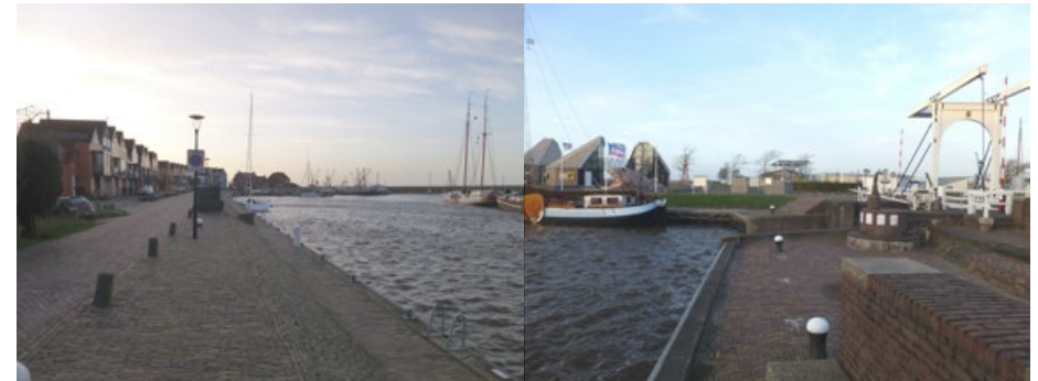
De ontwikkeling van de bebouwing in de havenmond van Stavoren hebben een 'schaalsprong' geïntroduceerd in Stavoren. De daarbij onstane restructuimten zijn nooit echt plekken geworden
