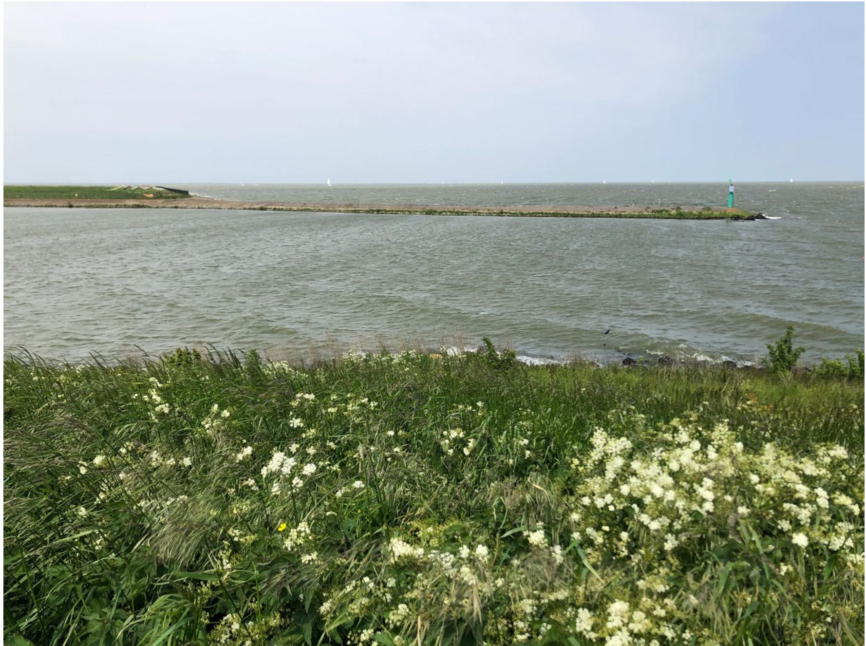
Zicht op de strekdam op het eind van het Andijk-terrein en vanaf de Westfriese Omringdijk
