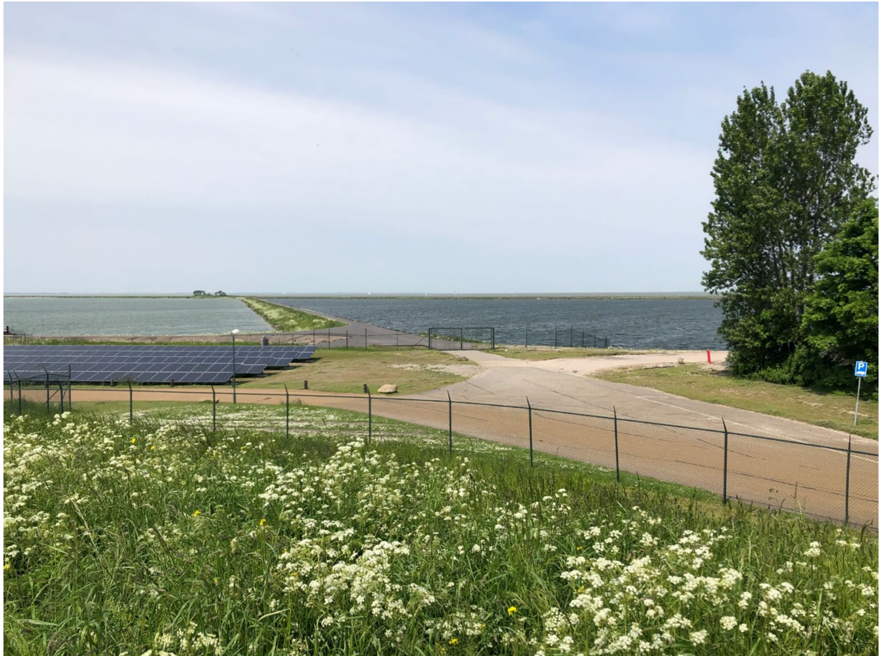
Zicht op de bestaande waterbekkens bij Andijk, met in het midden de dam die beide bekkens scheidt
